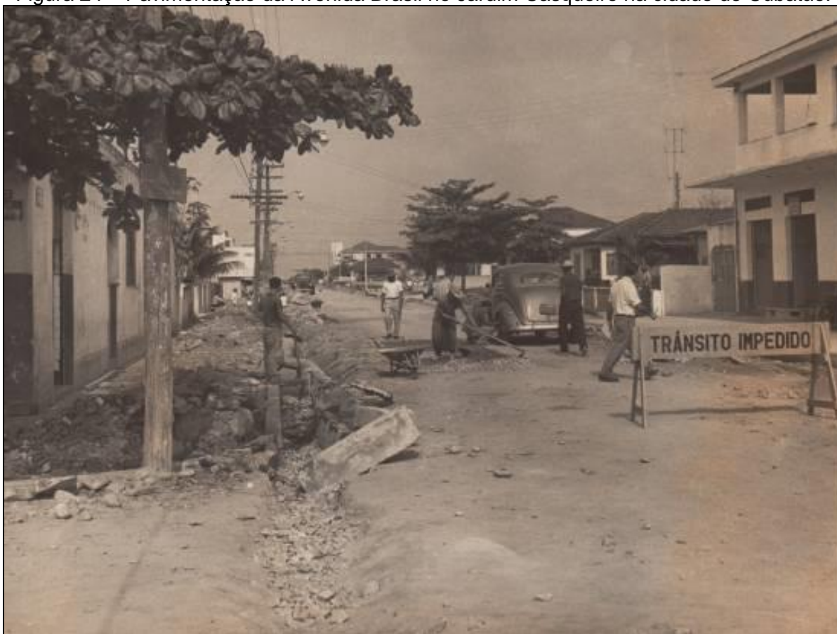
Figura 24 – Pavimentação da Avenida Brasil no Jardim Casqueiro na cidade de Cubatão.
