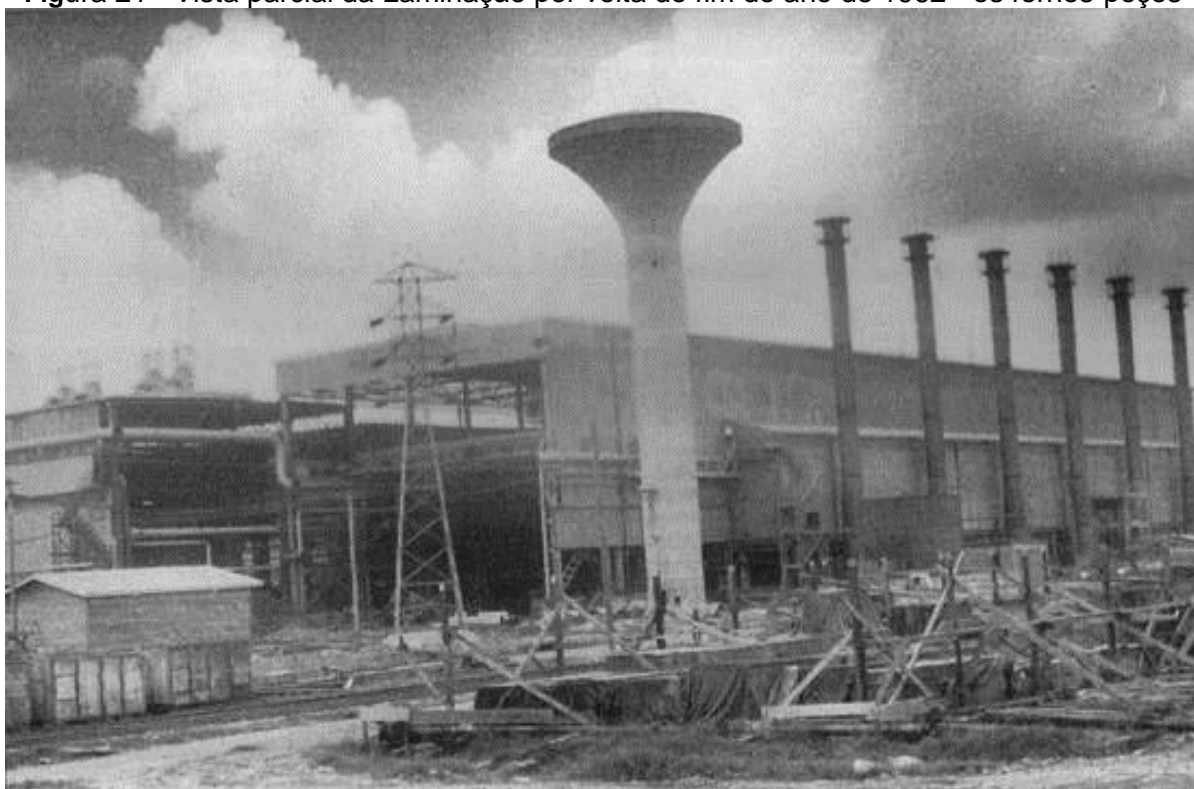
Figura 21 - Vista parcial da Laminação por volta do fim do ano de 1962 - os fornos-poços
