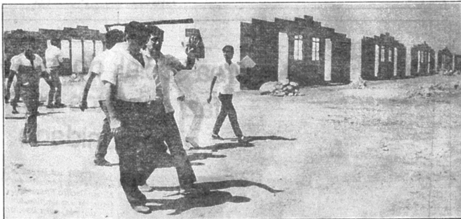
Comitiva esteve visitando obras de drenagem na Vila São José
