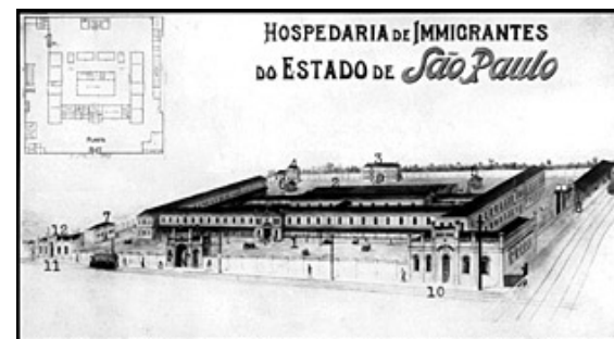
VISTA GERAL DO DEPARTAMENTO DE IMIGRAÇÃO E COLONIZAÇÃO - 1ª FASE ANTERIOR A 1911 - VENDO-SE: (1) Edifício Central: Administração e Dormitórios - (2) Refeitório e Cozinha - (3) Enfermaria - (4) Hospital - (5) Depósito de Frutas - (6) Sanitários - (7) Triagem Médica - (8) Estação e Bagageiro - (9) Portão Principal - (10) Agência Oficial de Colocação - (11) Agência Postal, Telégrafo e Câmbio - (12) Portão da Rua Almeida Lima
