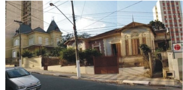
Residência Ramos de Azevedo, 1891 Fonte: Arquivo Denise Puertas de Araújo
