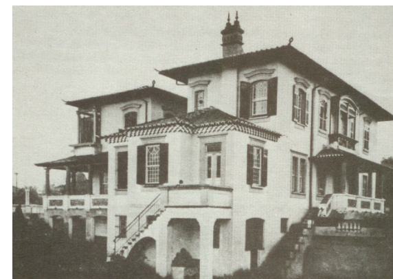
Vista dos fundos da mesma residência Fonte: LEMOS, Carlos Alberto Cerqueira. Alvenaria Burguesa. São Paulo: Nobel
