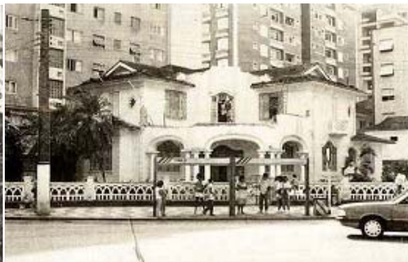
Figura 7: Demolição do Palacete Áurea Conde. Fonte: Site Novo Milênio
