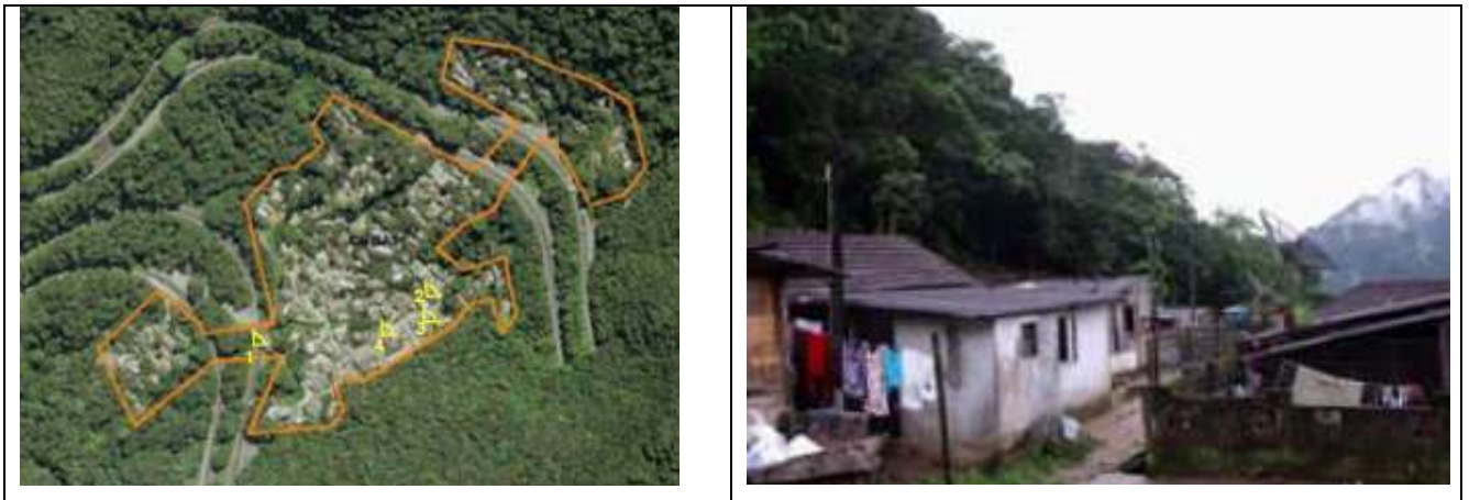
Figura__ - Cota 400 e suas habitações em situações de precariedade.
