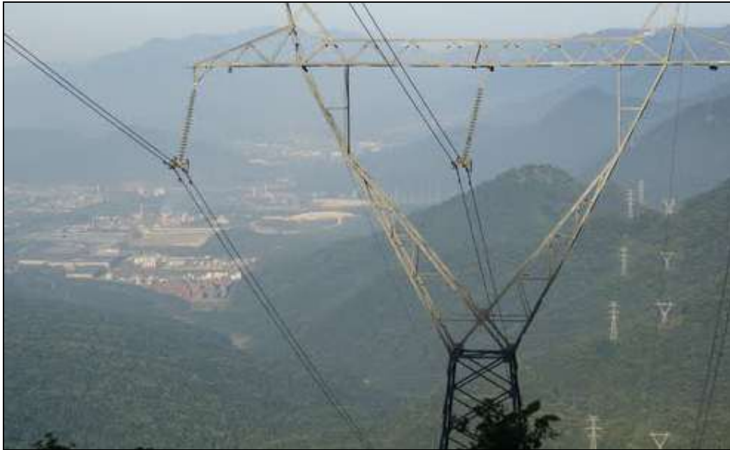
Foto 7.10.1 – Linha de transmissão de energia elétrica cortando o vale do Rio Mogi
