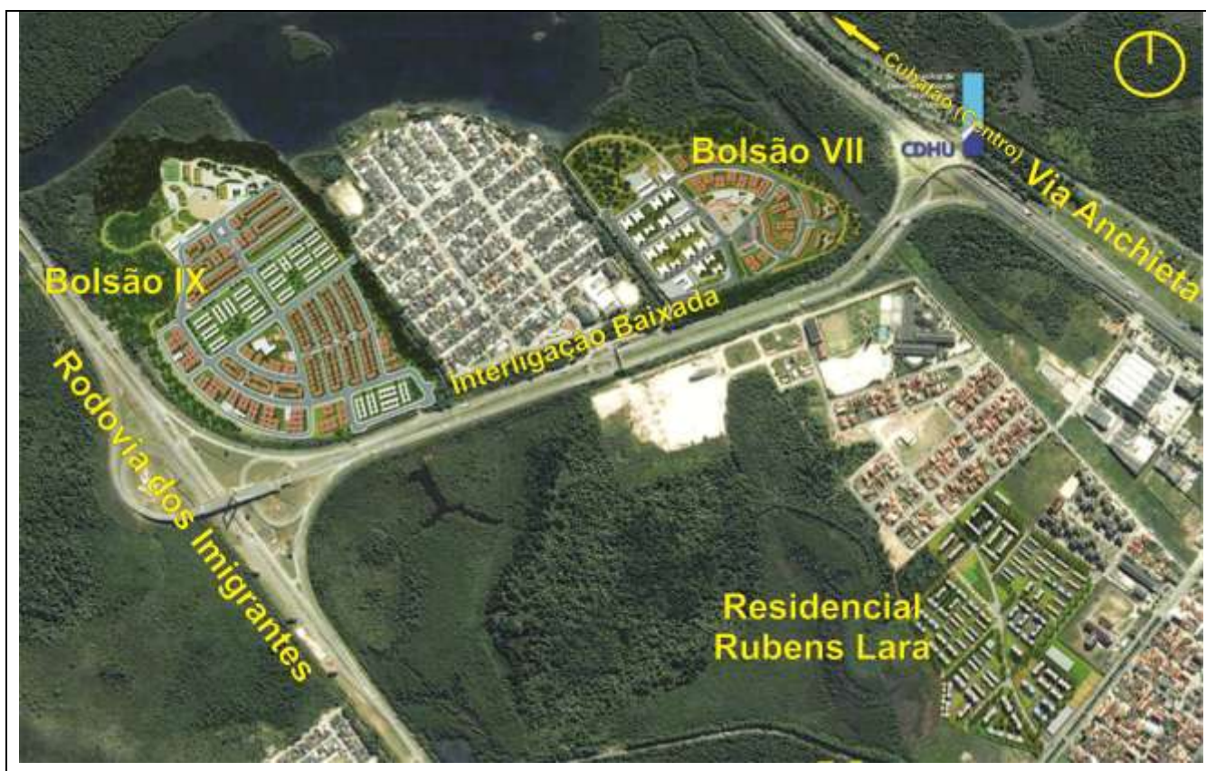
Figura. Infraestrutura viária na área dos empreendimentos habitacionais em construção pela CDHU, na área dos Bolsões e do Casqueiro.
