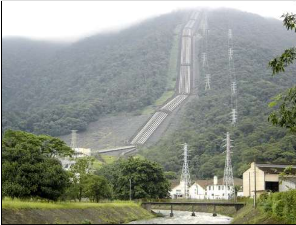
Foto 7.10 – Aquedutos da Usina Hidrelétrica Henry Borden e torres de alta tensão cruzando o Parque Estadual Serra do Mar
