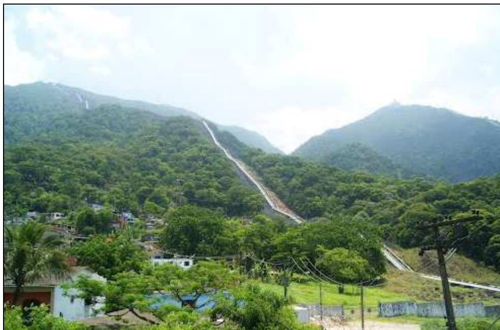
Foto 7.9 – Dutos da Petrobras cruzando o Parque Estadual Serra do Mar
