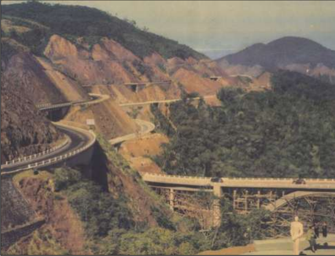
Foto 7.6 – Desmatamento realizado para a construção da SP
