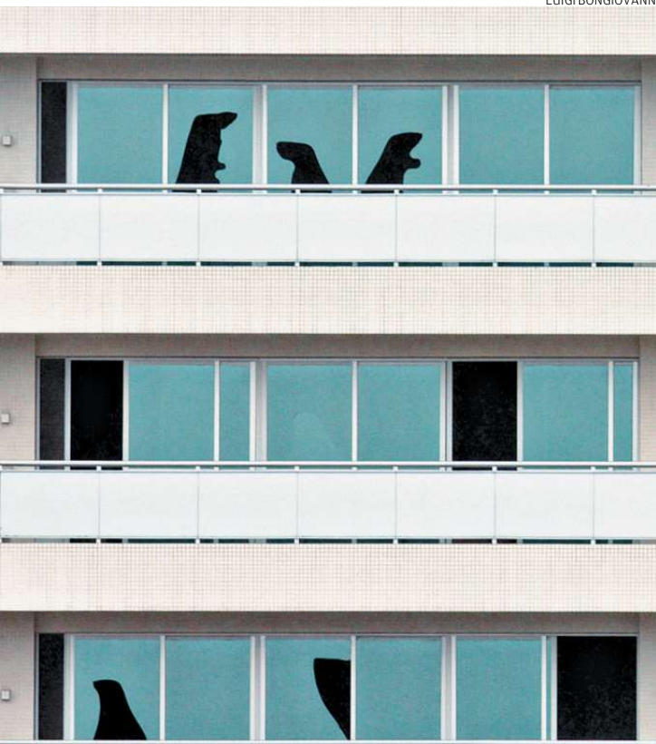
Vidros quebrados em janelas, efeito do acidente aéreo no Boqueirão
