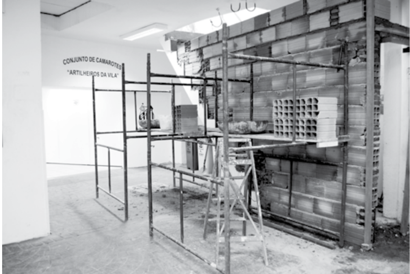
Vila Belmiro em obras: camarotes são modernos e confortáveis
